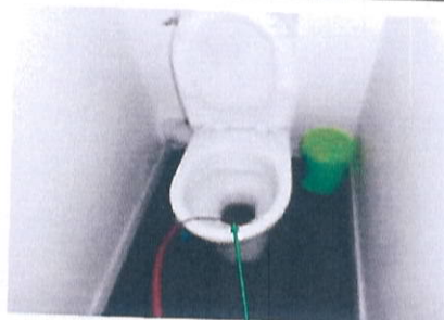
Inspection télévisée des EU par les WC
