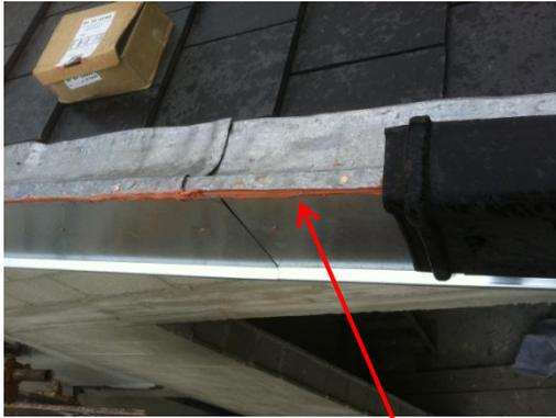
Réalisation du joint d'étanchéité
