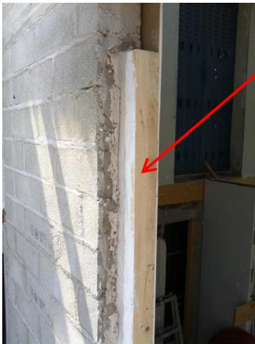
J'ai mis en place des chevrons permettant la fixation des glissières et de la menuiserie.
