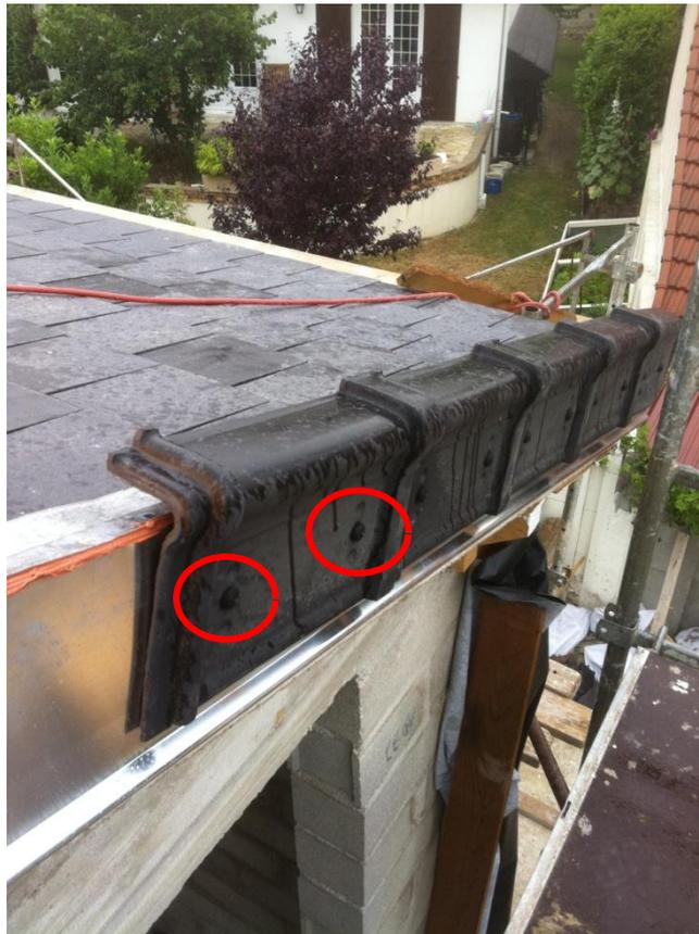
Mise en place des tuiles de rive puis fixation par clous vrrillés et frappés
