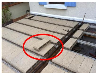
Les hourdies vont servir à porter la table de compression (béton coulé sur les poutrelles et les hourdies).
