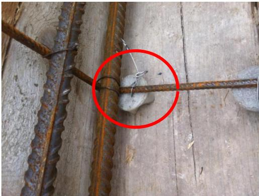
Je suis intervenu à cette étape du chantier pour placer les calles en béton sous les aciers pour que ces derniers soient positionnés au centre du futur linteau qui a été coulé en même temps que la dalle du premier étage.
