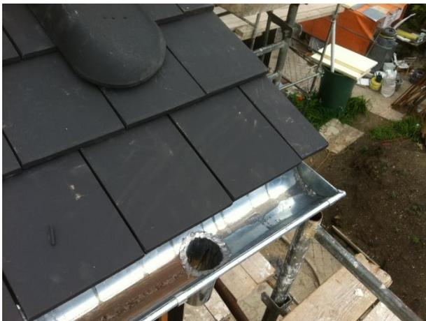
Mise en place de la gouttière en respectant la pente d'écoulement qui doit être de 1cm par mètre au minimum.
