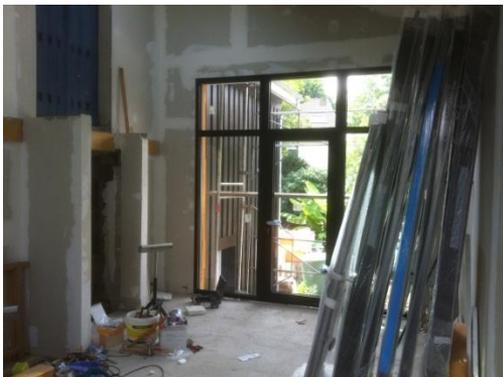
Fixation des montants en ayant retiré les vitres pour permettre d'accéder à la visserie des menuiseries.
