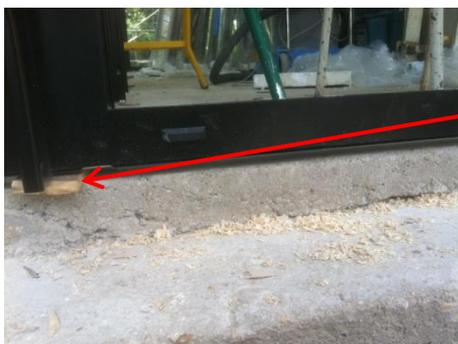
Lors de la fixation, j'ai procédé au réglage de la hauteur des montants grâce à de  fines calles permanentes. Ces dernières sont indispensables à l'ajustement des l'espace prévu pour la pose du carrelage.
