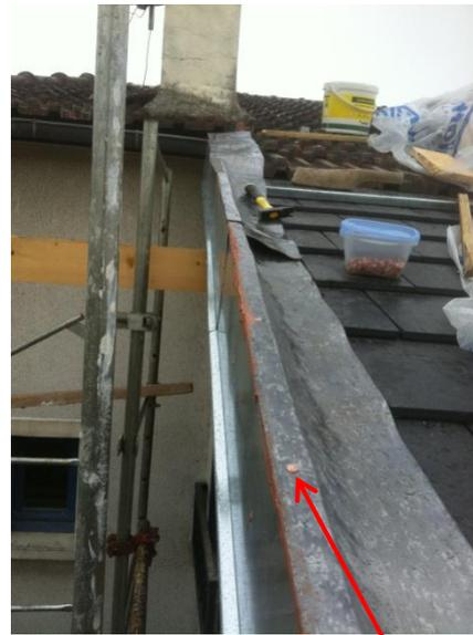
Positionnement puis fixation de la feuille de plomb grâce à des clous en cuivre
