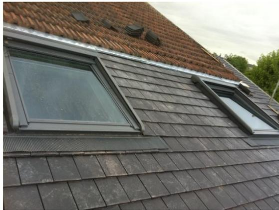
Mise en place du cadre et montage du velux
