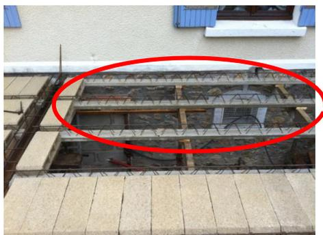
Les hourdies reposent sur les poutrelles grâce à leur forme spécifiques crantées qui leur permet de rester en place.
