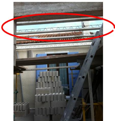
Les poutrelles sont placées à 60 cm d'intervalle et s'appuient d'un côté sur la future poutre et de l'autre sur le mur en parpaing.
