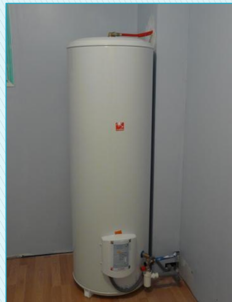
Sur le chantier
