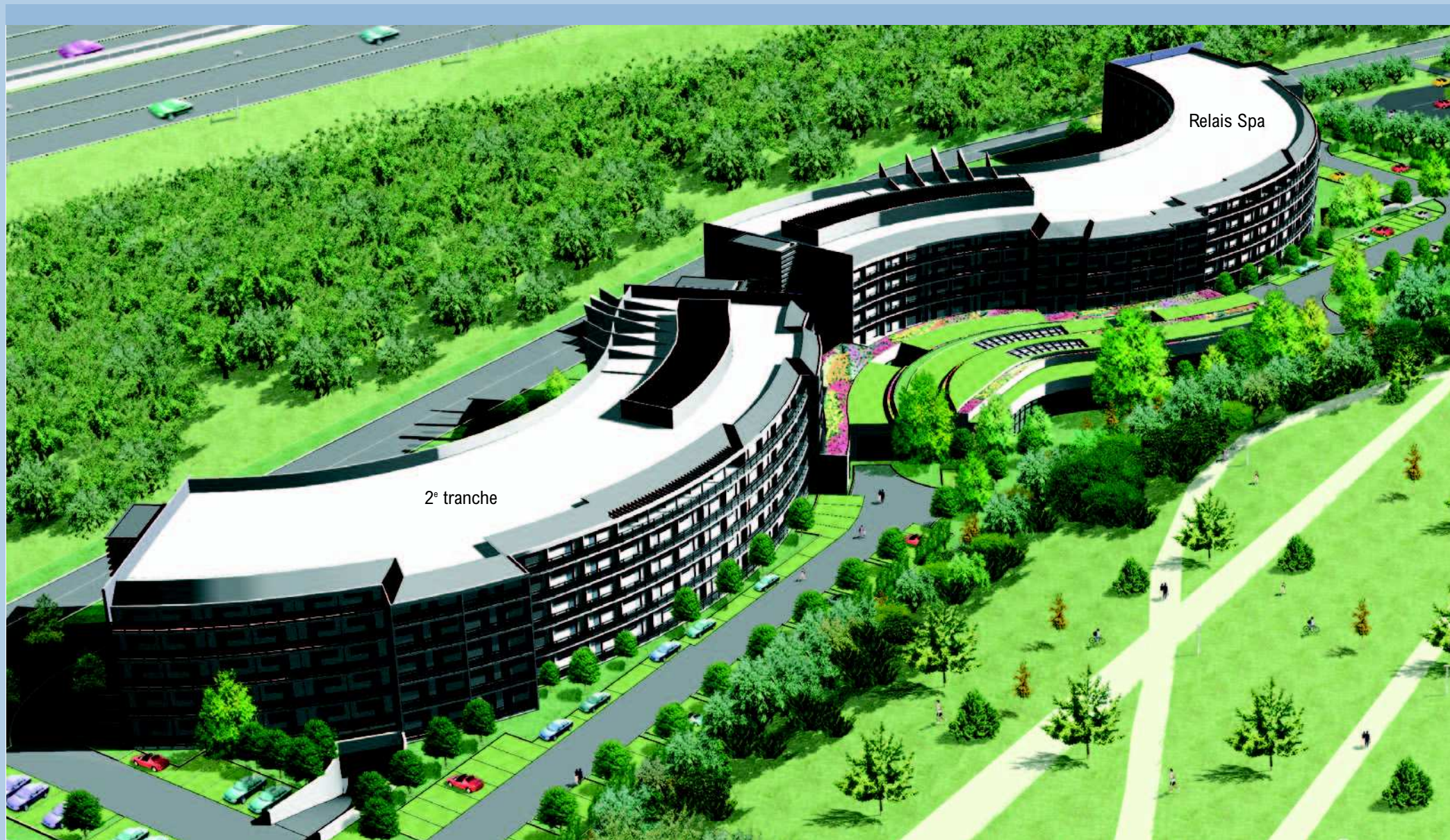
VUE AÉRIENNE DU RELAIS SPA ET DE LA FUTURE 2 E TRANCHE
