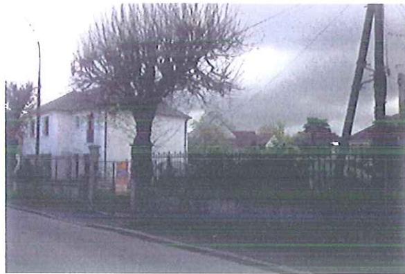
VUE AVANT TRAVAUX
