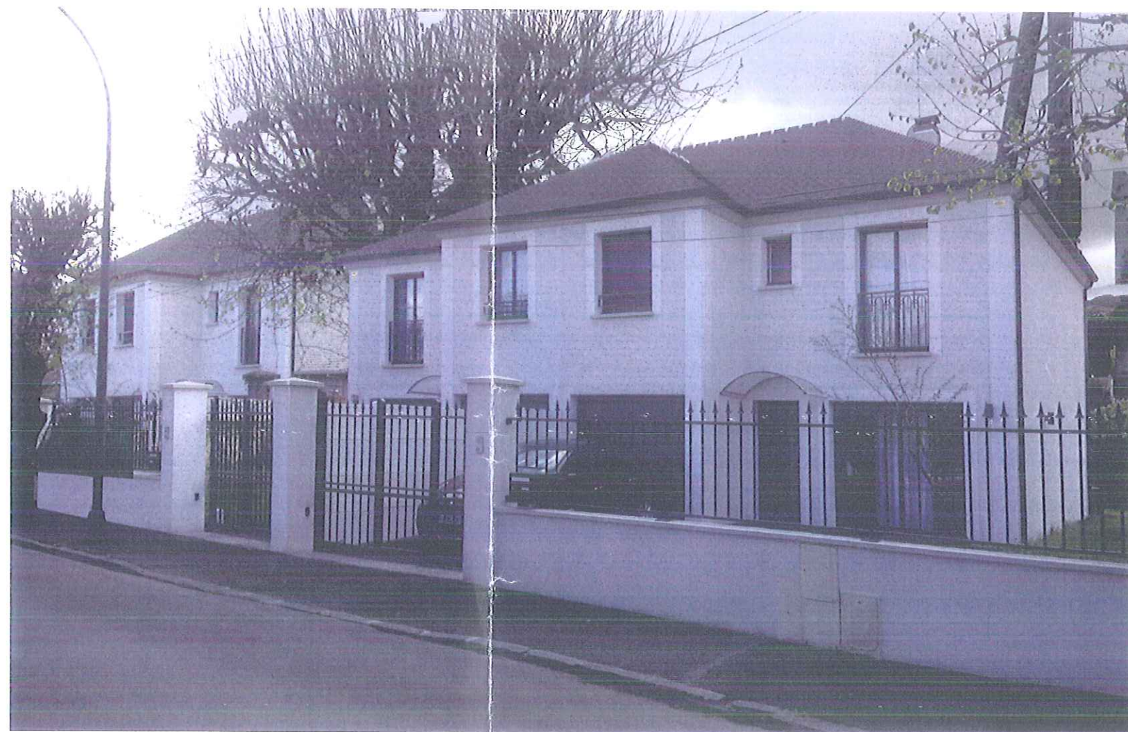
VUE APRES TRAVAUX
