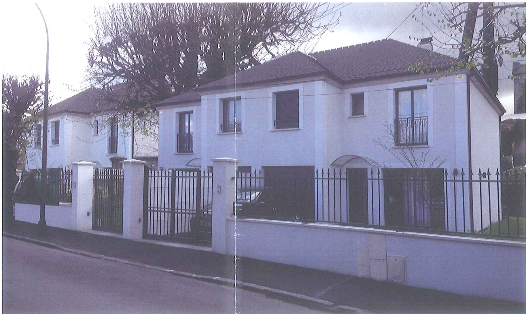
VUE APRES TRAVAUX
