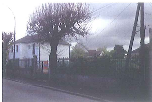
VUE AVANT TRAVAUX
