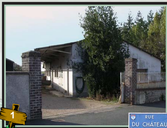
Future entrée du site - bâtiments agricoles à détruire
