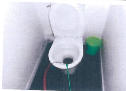
Inspection télévisée des EU par les WC
